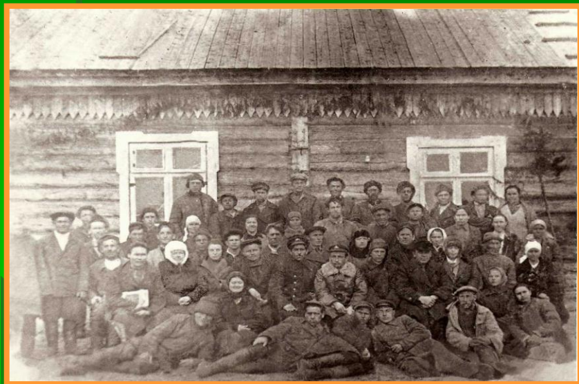
1934г. Здание культбазы
